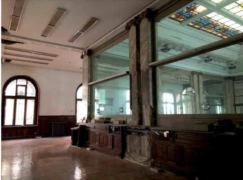
*Detalle columnatas de patio de operaciones y de pruebas estructurales sobre las mismas*
