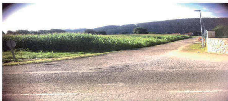
En la parte izquierda una vista parcial de la parcela nº 27 del polígono 5 de 7.876m2. A la derecha se encuentra construida una vivienda unifamiliar. Enfrente hay 5 viviendas construidas y dos en construcción Todas a unos metros de las antiguas escuelas y casas
