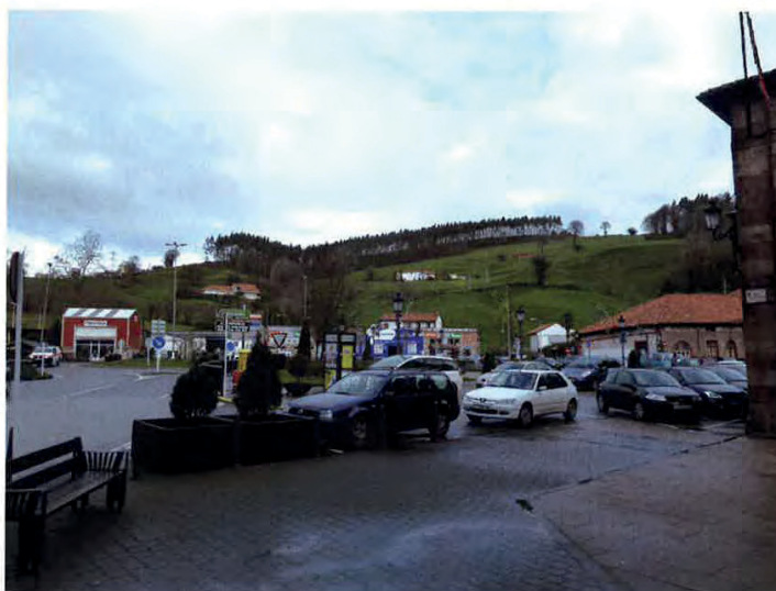
Figura 6. Al fondo la ladera, detrás de los edificios de la zona de Las Tueras, vista desde La Plaza donde se ubica el Ayuntamiento
