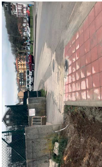
Arquetas a pie de parcela (abastecimiento, saneamiento, electricidad y telecomunicaciones)
