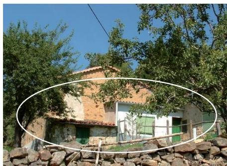
*Ejemplos de alteraciones. Construcción de anexo sobre fachada principal. Instalación de caseta de aperos en fachada principal (dcha.).*
