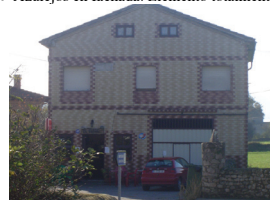
Imagen 14.- Azulejos en fachada. Elemento totalmente inadecuado.
