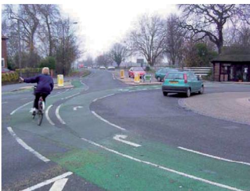
*Imagen 20. Carril bici exterior sobre la calzada de glorieta*
